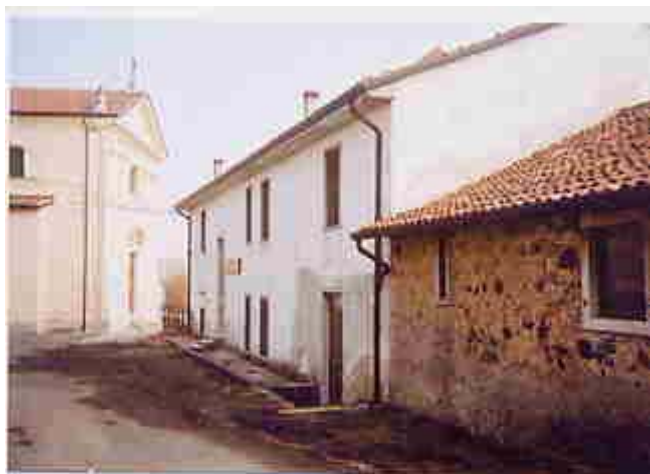
L'esterno della Base
